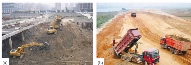
(a) 开挖基坑产生的土体材料; (b) 开挖的土体被用来路基建设 ③
